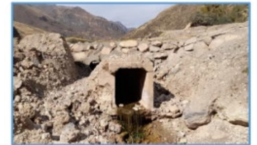
Alcantarilla existente visto desde aguas abajo
